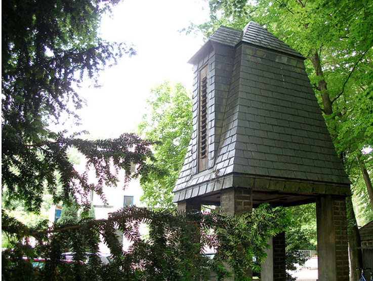
Figuur 11 Voorbeeld van een vleermuistoren uit 1916
